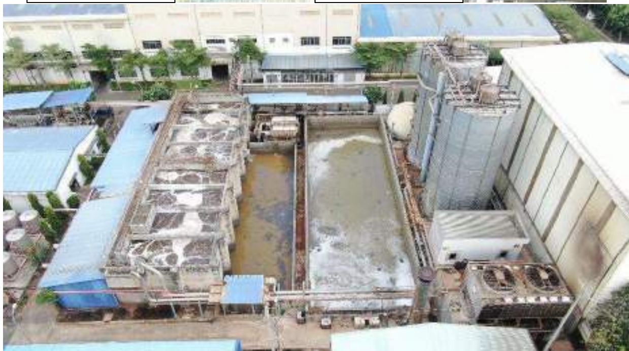
Các hạng mục xây dựng hệ thống xử lý nước thải tập trung
