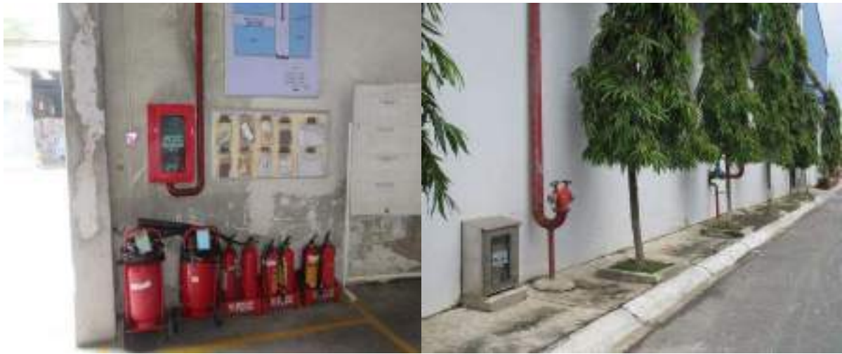
Thiết bị PCCC và hệ thống chữa cháy vách tường của kho chứa phế liệu
